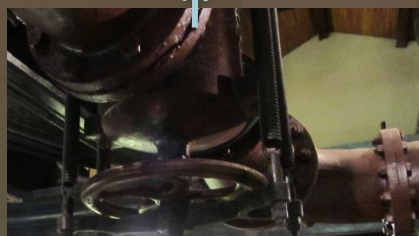
Arrivée d'air de la chaudière
