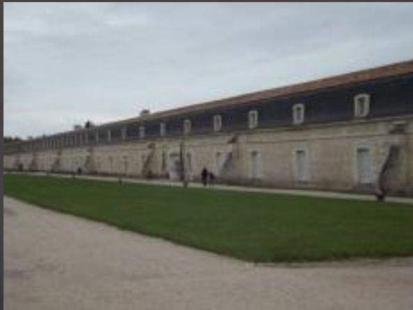
Corderie Royale de Rochefort (1666, début des travaux) Toute en longueur pour s'adapter aux lignes de production.
